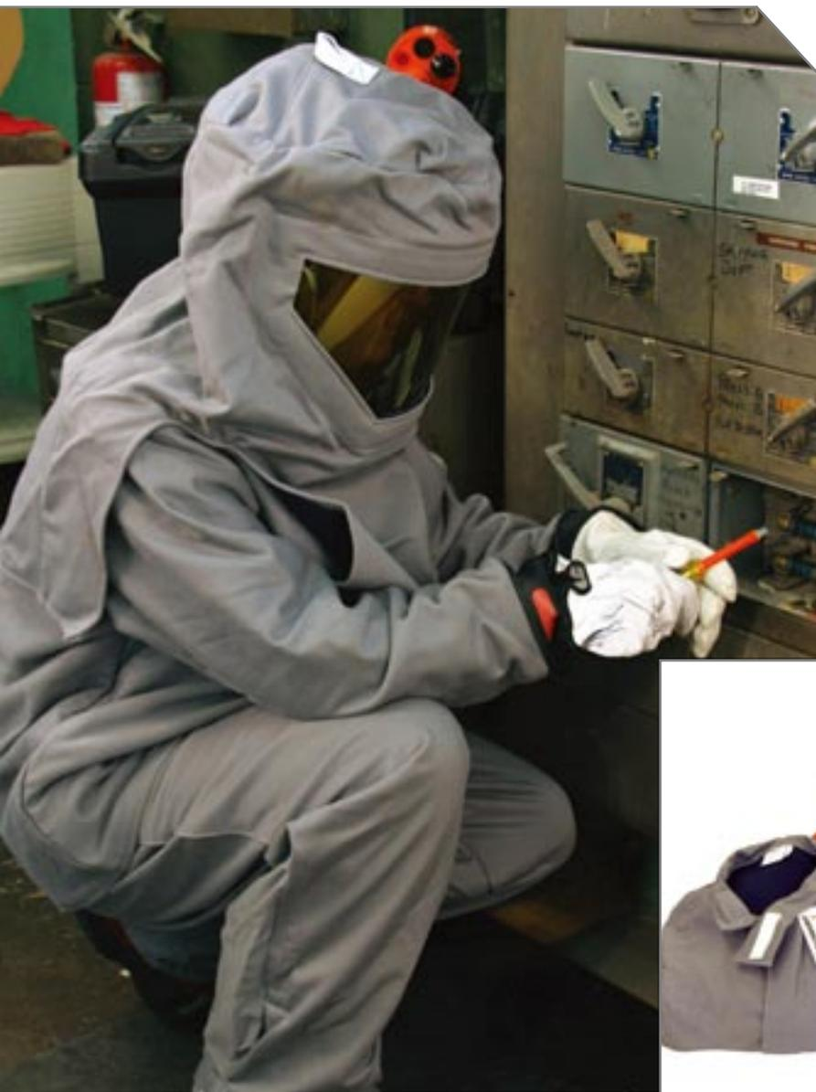
◀ 此Salisbury PRO-WEAR™ 电弧防护装备套件的ATPV为100 cal/cm<sup>2</sup>。这个套件包括电弧防护上衣，背带裤，PRO-HOOD®，防电弧头罩，储存包和安全眼镜。
